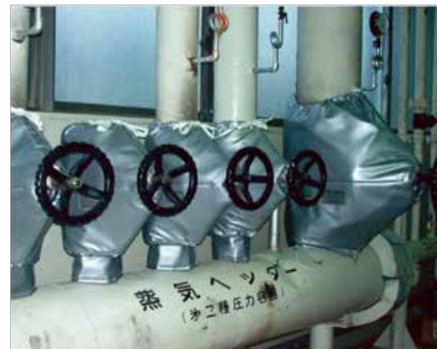
図 2 蒸気ヘッダ部バルブの保温状況例
