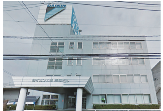
地上4階 / 塔屋1階・延床面積 2,620m 2 中規模オフィスビル（福岡県）
