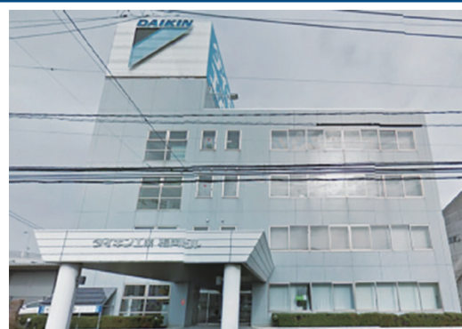
地上4階/塔屋1階・延床面積2,620m 2 中規模オフィスビル（福岡県）
