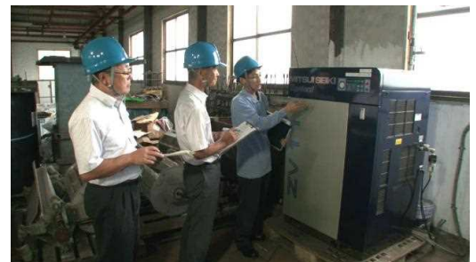
<現場でのエネルギー使用状況確認>
